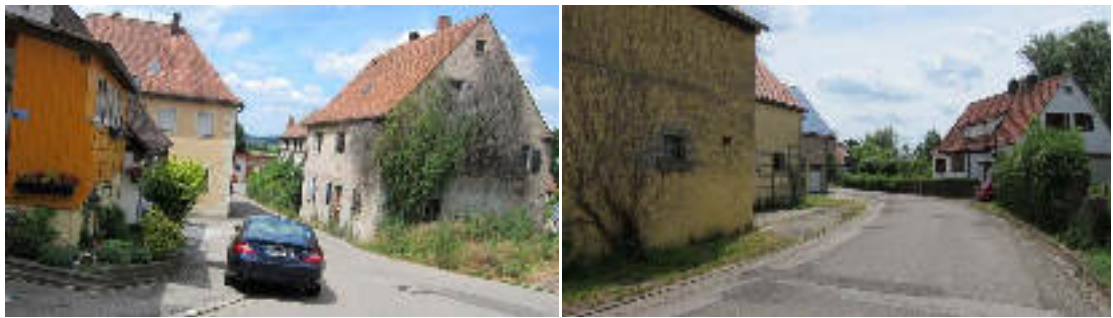
Sanierungs- und Gestaltungsbedarf: Schäden im Bereich Häffnersplatz und der südl. Rezatstraße
