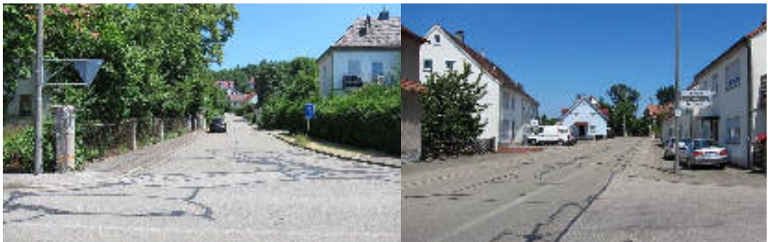
Sanierungs- und Gestaltungsbedarf am Felsenkeller und in der Ballstadter Straße
