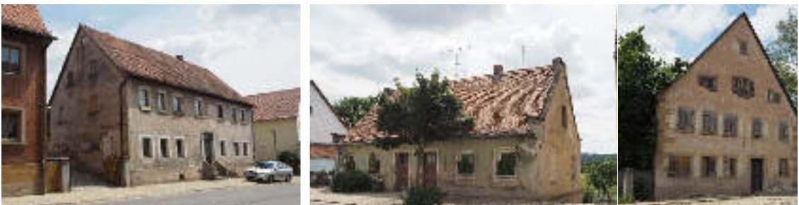
Gebäudeleerstand/Unternutzung in Hauptgebäuden in der Ortsdurchfahrt Untere Hindenburgstraße 7, 48 und Obere Hindenburgstraße 44
