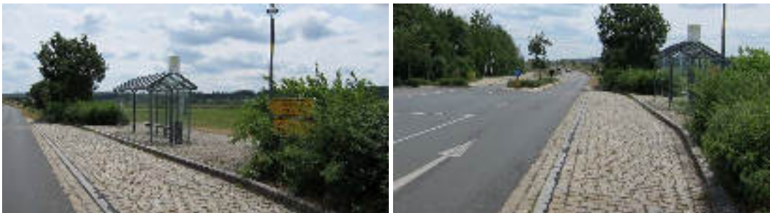
Untere Hindenburgstraße/ südl. Ortseingang: Busbucht, Buswartehalle und Fußgängerinsel /Fahrbahnleiter
