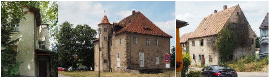
Weitere ortsbildprägende Gebäudeleerstände: Ballstadter Straße 16, Schulweg 3, Häffnersplatz 3
