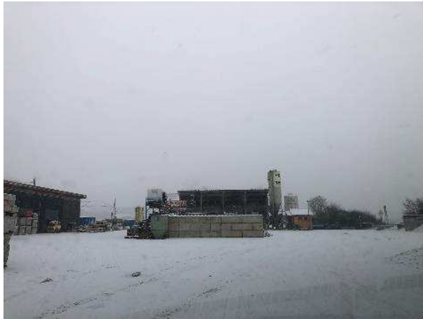
Bild 3: Bestandsgelände mit Betontankstelle
