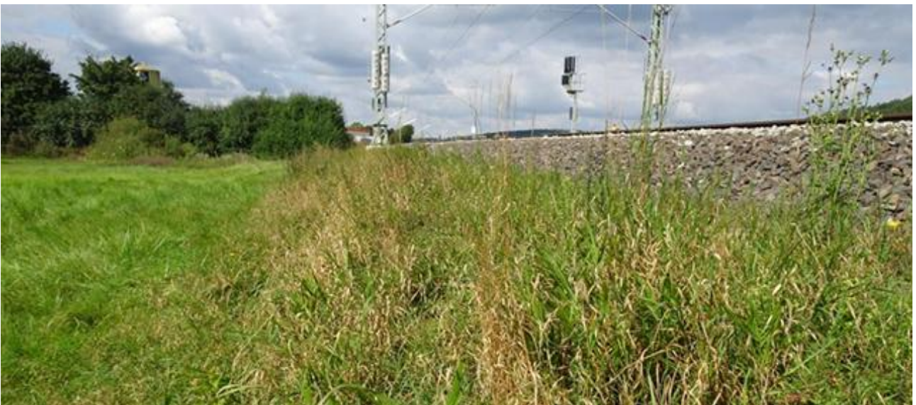
Abbildung 8: Der Bahndamm im Osten des Vorhabensgebiets (Foto: Bachmann Artenschutz GmbH)
